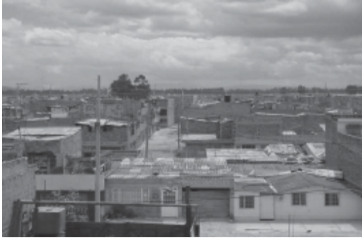
Fotos 2 y 3: Localidad de Bosa en Bogotá. Producción física promovida por los pobladores. Autoconstrucción y desarrollo progresivo. (Fotos del autor).
