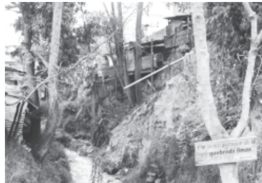
Fotos 6 y 7: Los temas medio ambientales en los barrios populares periféricos son complicados, en la primera foto se aprecia un problema muy común, la no pavimentación de las vías lo cual genera problemas de salud en estas comunidades. En la siguiente foto otro problema también común: la invasión de las rondas de ríos y quebradas urbanas. (Fotos del autor).
