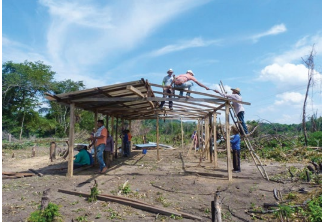
↑ Varios campesinos de Las Pavas, en un trabajo colectivo y solidario, están construyendo una casa para una familia que retornó al territorio en el año 2015.
