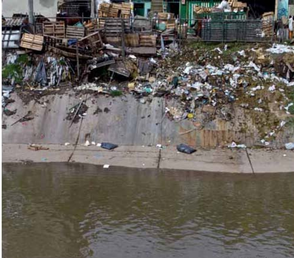
FOTOGRAFÍA DE GUILLERMO SANTOS. Descarga de basuras al canal del río Fucha en la zona de Los Comuneros.
